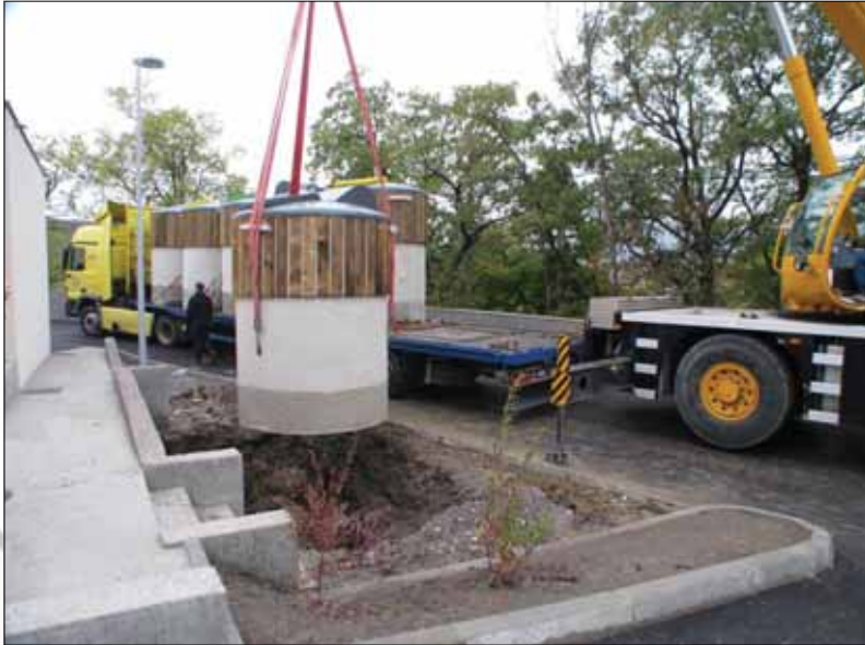
Plaatsing van Tiërso's in Gap (Frankrijk) na het dichtgooien van de bouwput is het systeem klaar voor gebruik.
