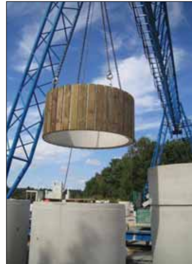
Plaatsing van Tiërso's in Gap (Frankrijk) na het dichtgooien van de bouwput is het systeem klaar voor gebruik.
