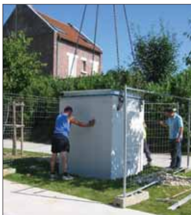
De betonsilo wordt in de voorbereide bouwput geplaatst.
