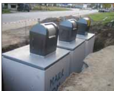
De betonsilo wordt in de voorbereide bouwput geplaatst.
