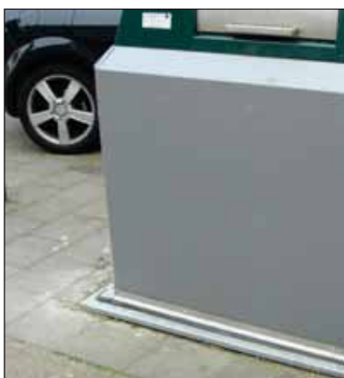
Een profiel dicht de kier tussen groundbak en container af, zodat er geen zand of bladeren in kunnen waaien
