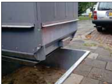
De groundbak is van onder open, zodat er geen water in blijft staan
