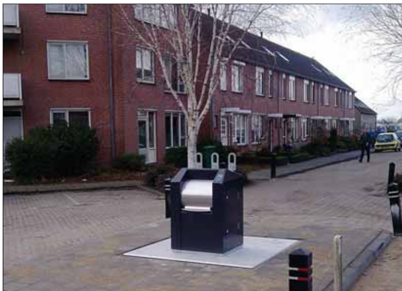
Één van de twee perscontainers in gemeente Made- Drimmelen
